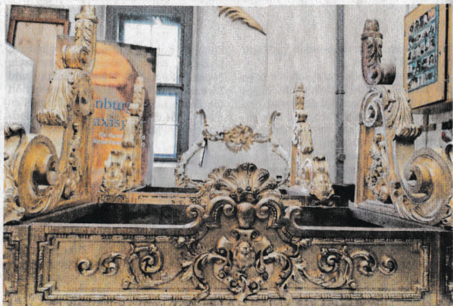
Im Zuge der Arbeiten galt es, viele Fehlstellen auszubessern. Dem ging eine umfassende Analyse voraus.
